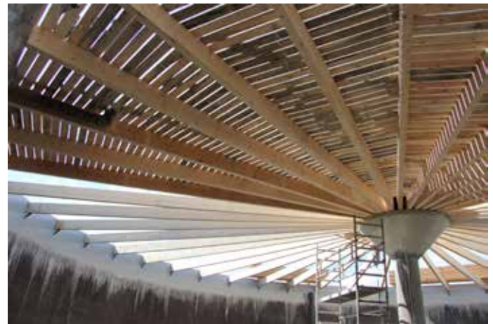
Abb. 5: Holzdecke Innenansicht auf Balken und Schalungsbretter eines baugleichen Fermenters
