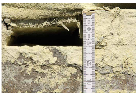
Abb. 5: Ansicht einer Sparrenauflage im Behälterrand
