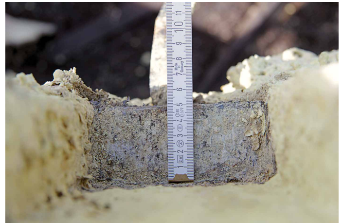
Abb. 10: Auflagetaschen für die Sparren am Behälterrand
