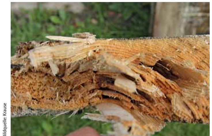
Die Holzzerstörung erfolgt – wie dieses Bild zeigt – nicht nur äußerlich, sondern auch im Inneren der Sparren
