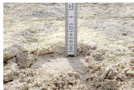
Abb. 2 und 3: starke gelbe Ablagerungen unter und auf der Dachfläche und an den Sparren
