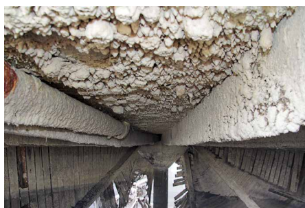
Abb. 2 und 3: starke gelbe Ablagerungen unter und auf der Dachfläche und an den Sparren
